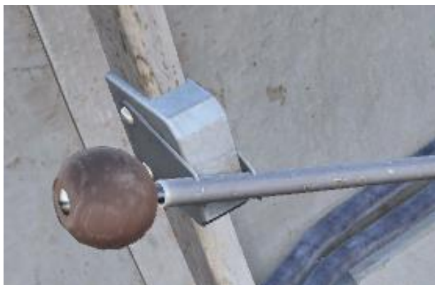
Рисунок 62: Ручка управления пожарным краном
